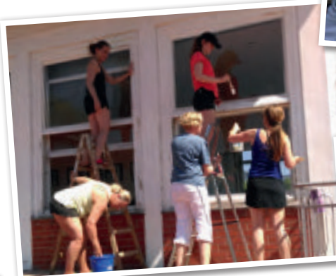
Arbeiten: gemeinsam haben wir bei schönstem Wetter die in die Jahre gekommenen Fensterrahmen abgeschmirgelt und neu gestrichen
